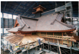
瓦屋顶的完成（2009年）
