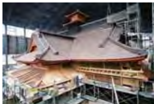
ติดตั้งกระเบื้องหลังคาเสร็จ (เดือนเม.ย ปีเฮเซที่ 21)
